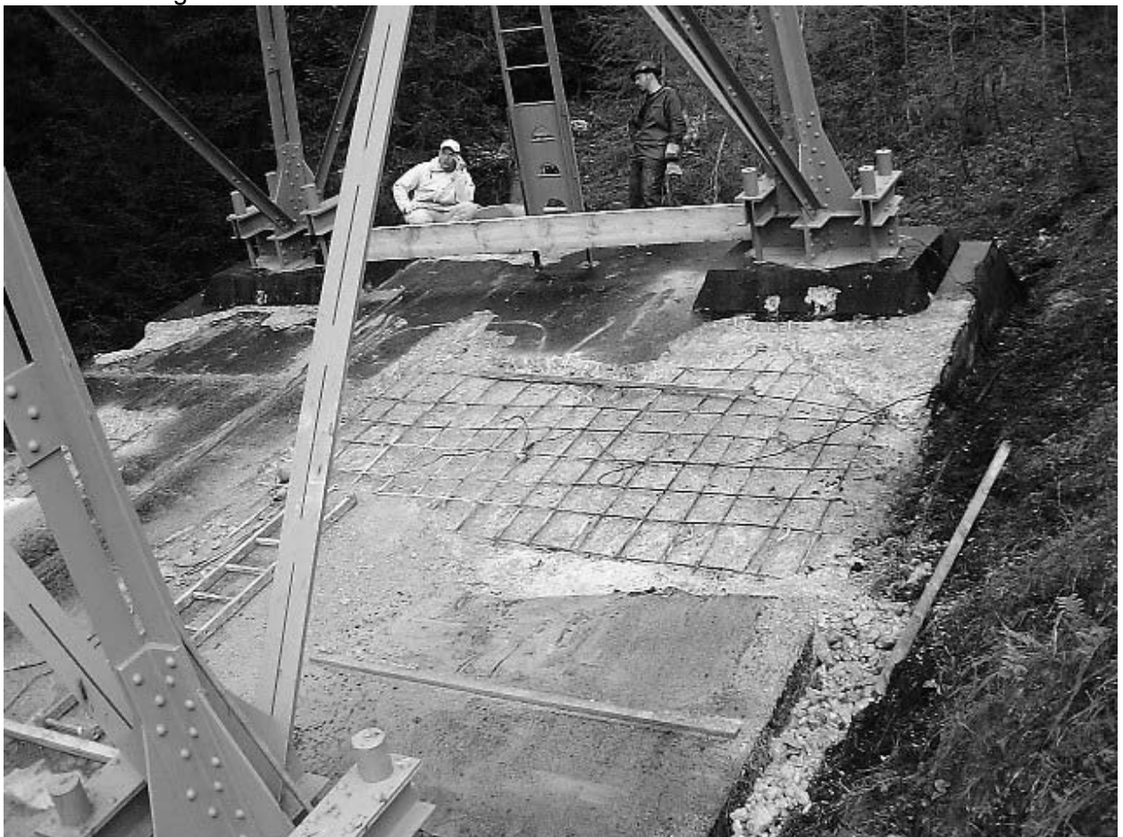
Betonsanierung am Fundament der Stütze 1.
