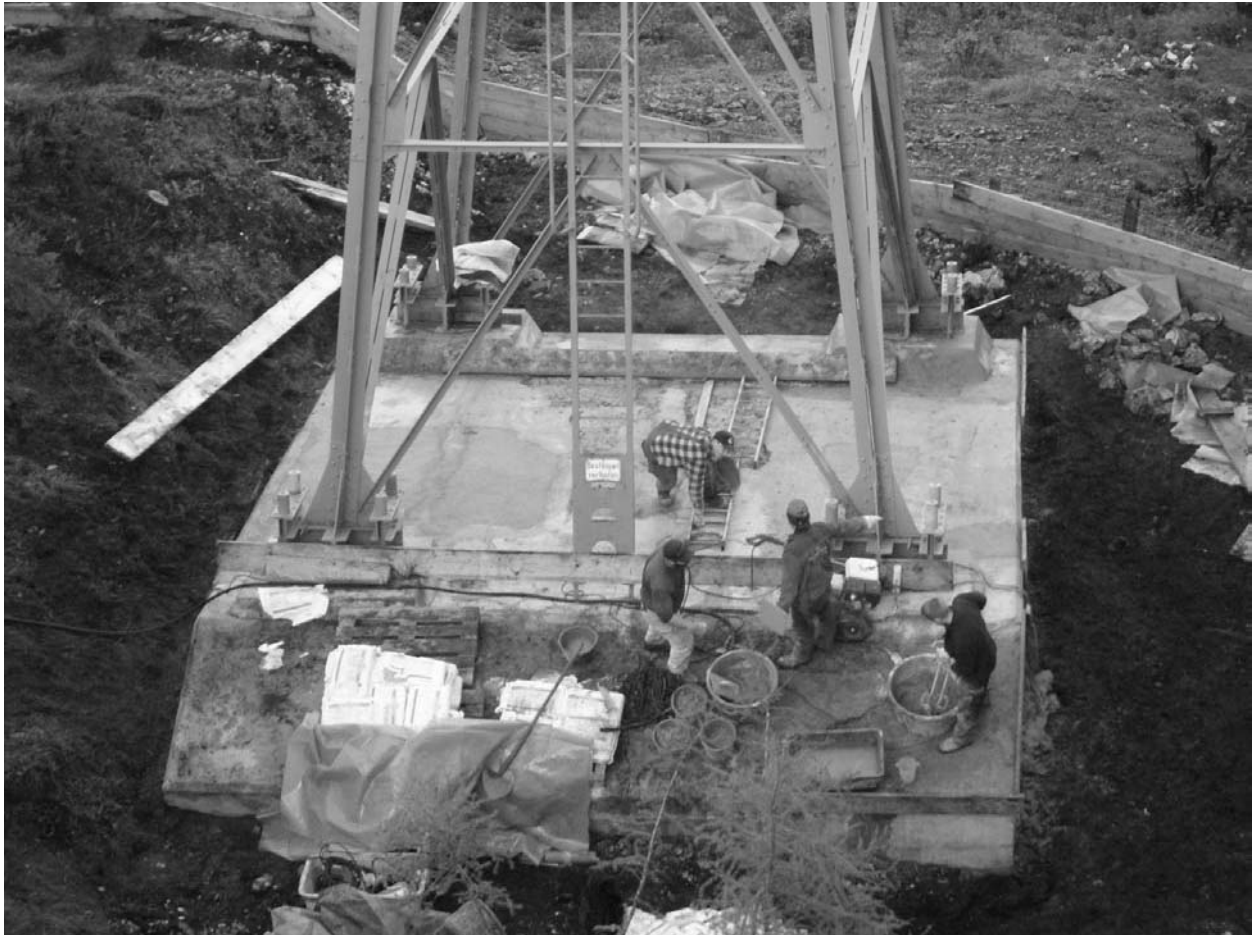
Betonsanierung am Fundament der Stütze 1.
