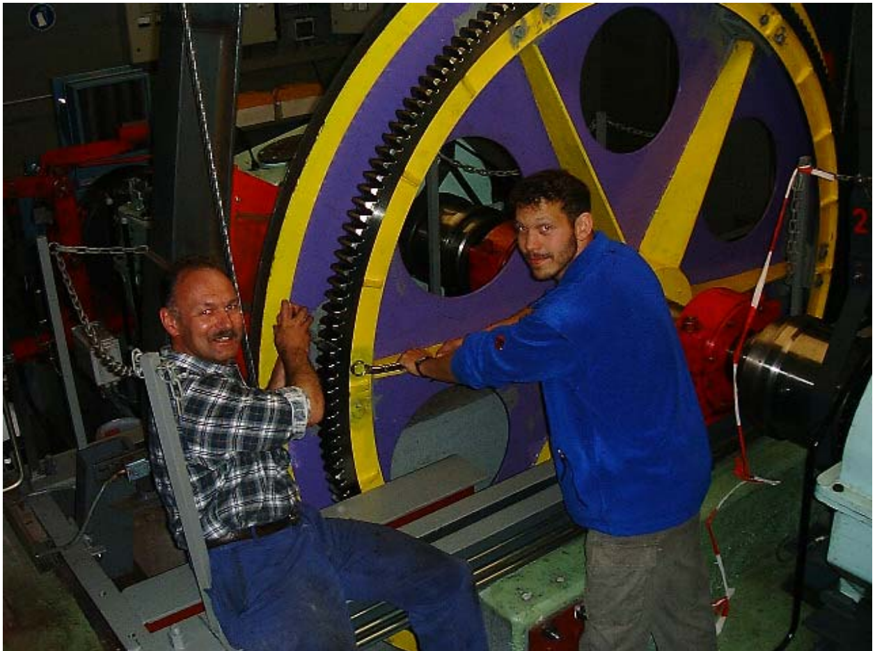
Anbau des Zahnkranzes an die Antriebsscheibe durch Mitarbeiter der Karwendelbahn AG.
