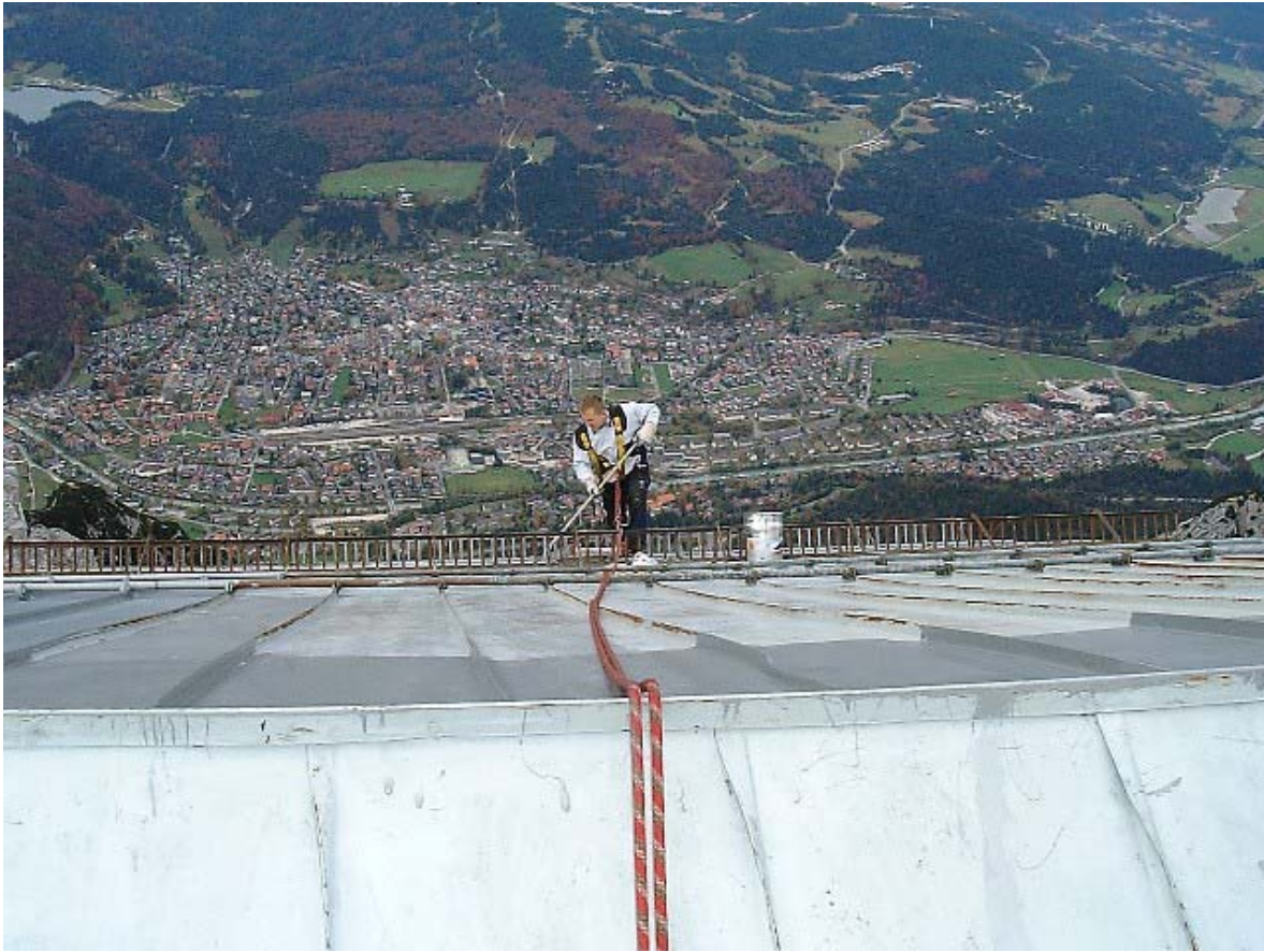
Dachsanierung Stationsgebäude Berg.
