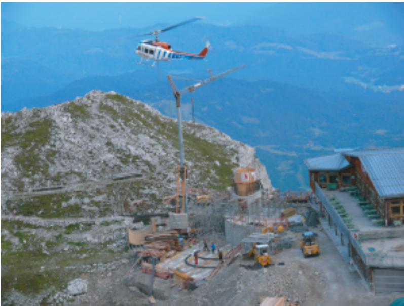
(Versorgungsflüge mit Baustahl zum Naturinformationszentrum)
