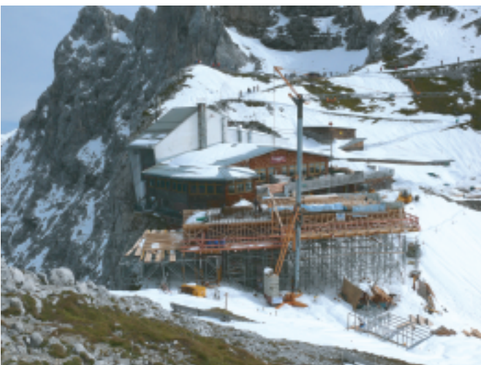
(Wintereinbruch auf der Baustelle des NIZ im Juli)
