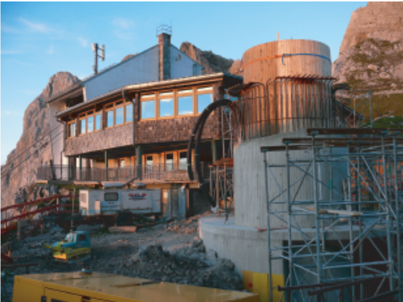
(Treppenturm des Naturinformationszentrums im Rohbau)
