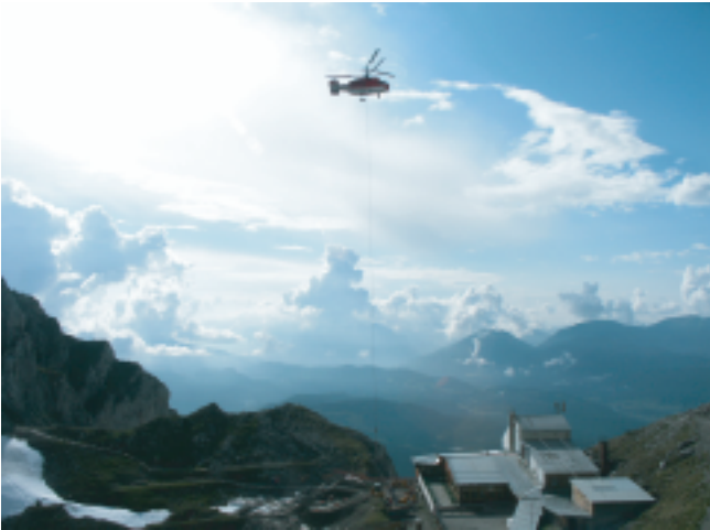
(Schwerlasthubschrauber Typ „Kamov KA 32“ über der Bergstation beim Absetzen einer Baumaschine)
