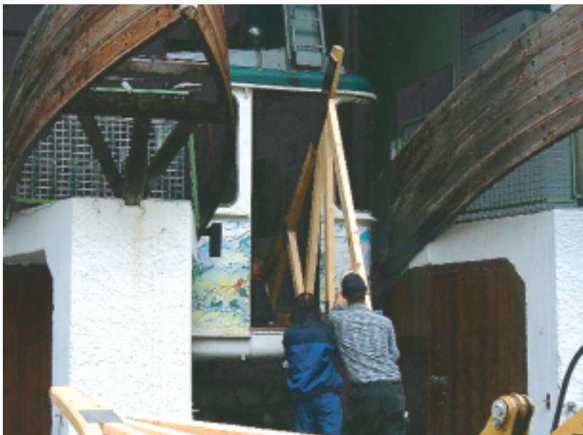
(Verladen von Holzbindern in die Seilbahnkabine)
