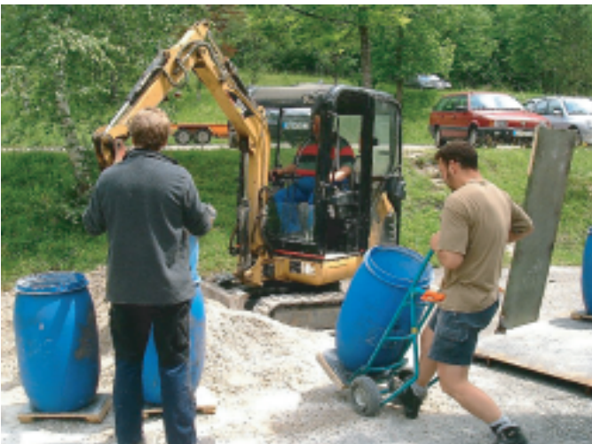
(Abfüllen der Kunststofffässer mit Betonkies in der Talstation)
